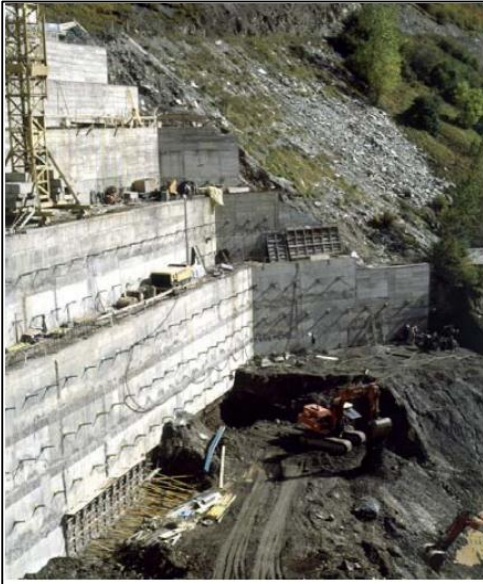
Figura 10. Muros de Gravedad
