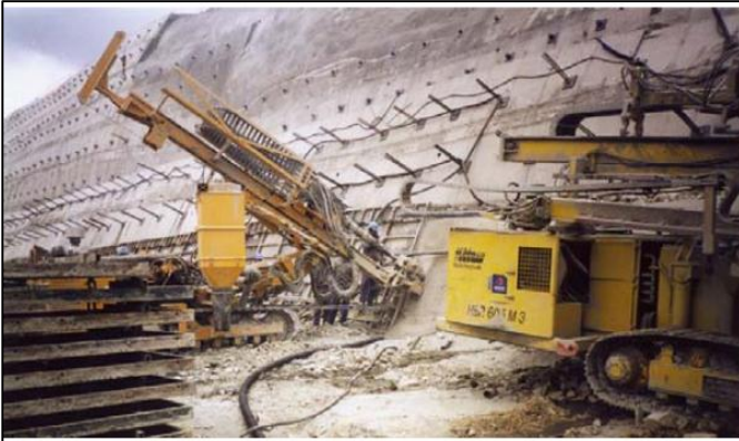
Figura 11. Anclado de Refuerzo en Terreno.
