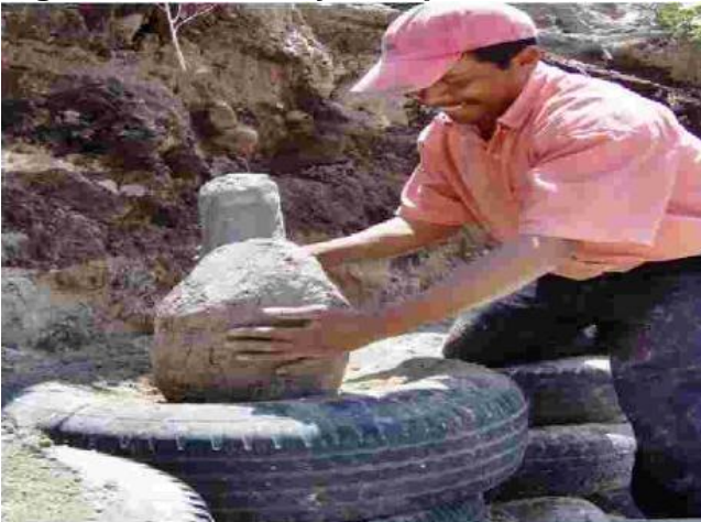
Figura 21. Relleno y Compactación de Llantas
