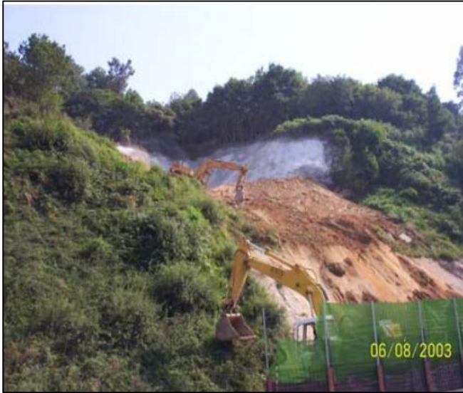
Figura 6. Desmante de Tierra para Descargar Talud
