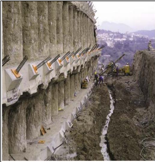
Figura 13. Ejecución elementos Profundos Mediante Pantallas
