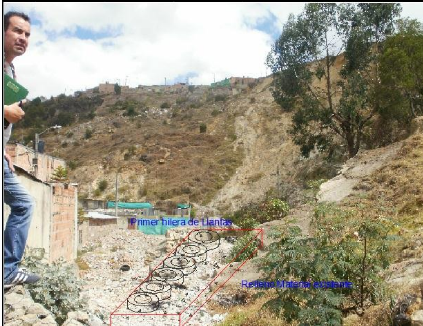
Figura 23. Bosquejo Primera Hilera del Muro de Llantas para la Estabilización de Taludes
