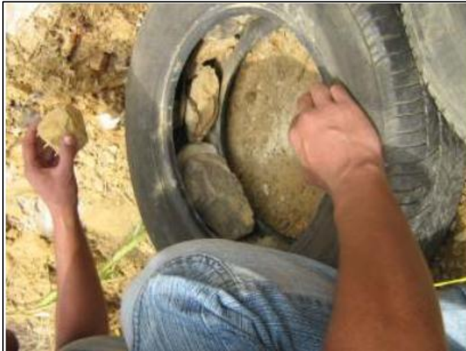
Figura 4. Relleno de Llantas con Rocas para Dar Solidez y Mayor Peso a la Estructura
