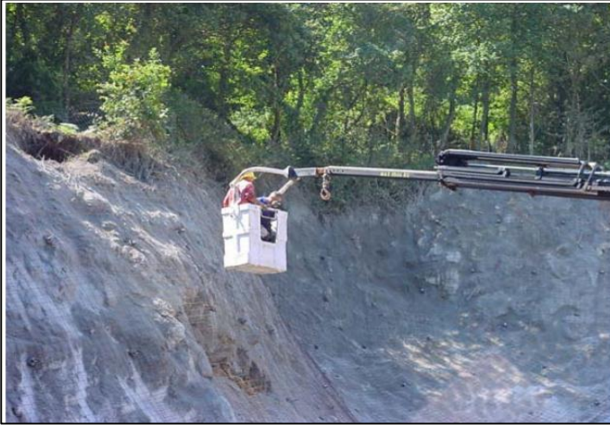
Figura 8. Refuerzo Semiprofundo para Coser Tapas Terreno Inestable
