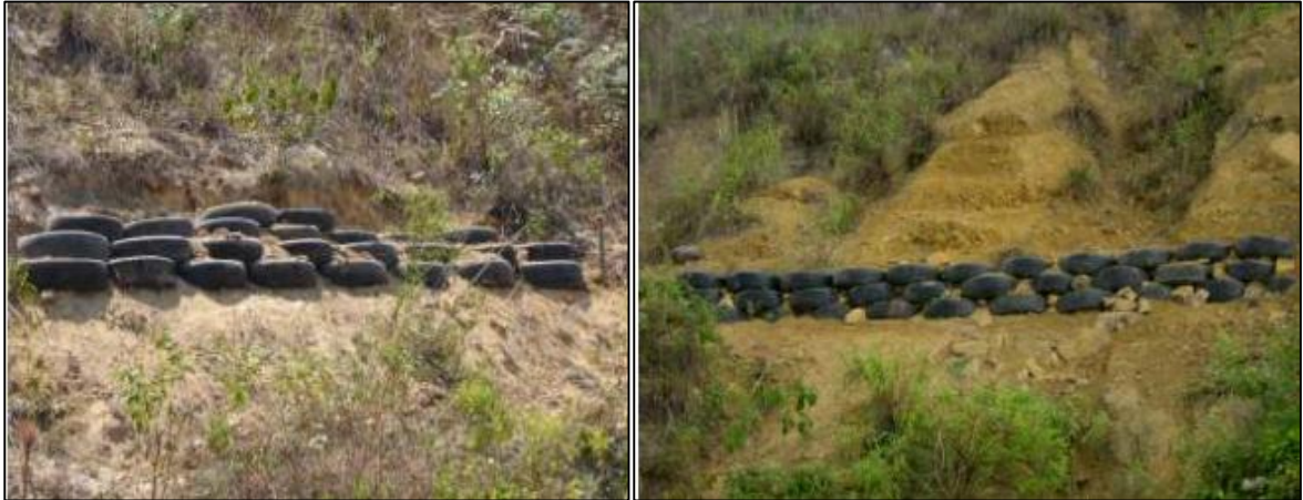
Figura 3. Trinchos con Llantas Recicladas – Cali Colombia, Antes – Después
