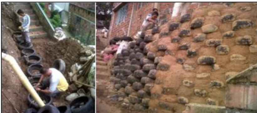
Figura 2. Barrió Fuente Clara – Medellín Colombia, Construcción de Muro con Llantas Recicladas
