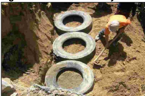
Figura 19. Conformación y Nivelación del Terreno
