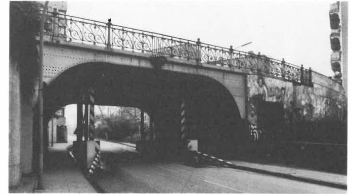
Abb. 8: Hochstraßenbrücke 1983 von Süden (Baubehörde Hamburg)
