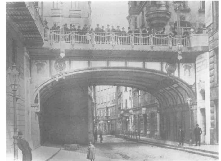
Abb. 11: Hohe Brücke in Wien, Ansicht vom Tiefen Graben 1904, nach: K. Christl (s. A 14)
