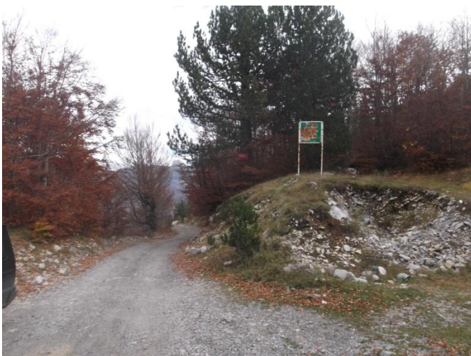
Ch. 3+577m Fundi i seksionit te pare.
