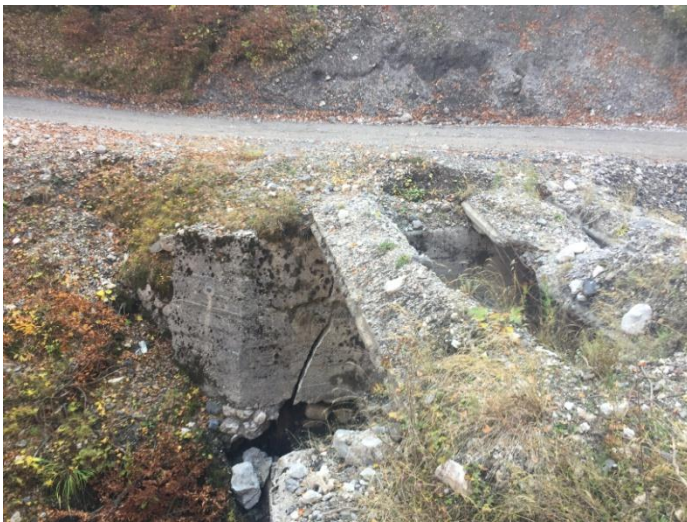
Ch 7+575 struktura ekzistuese
