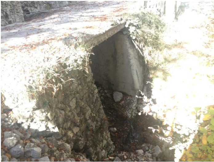
Ch 12+400 struktura ekzistuese
