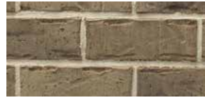
JBP231 Ross Bridge EST 790375
