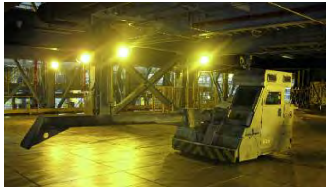
POSCO FeSi plant.
