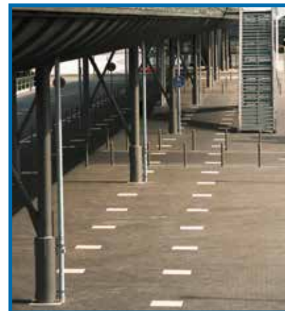
...an öffentlichen Bauten ...public buildings
