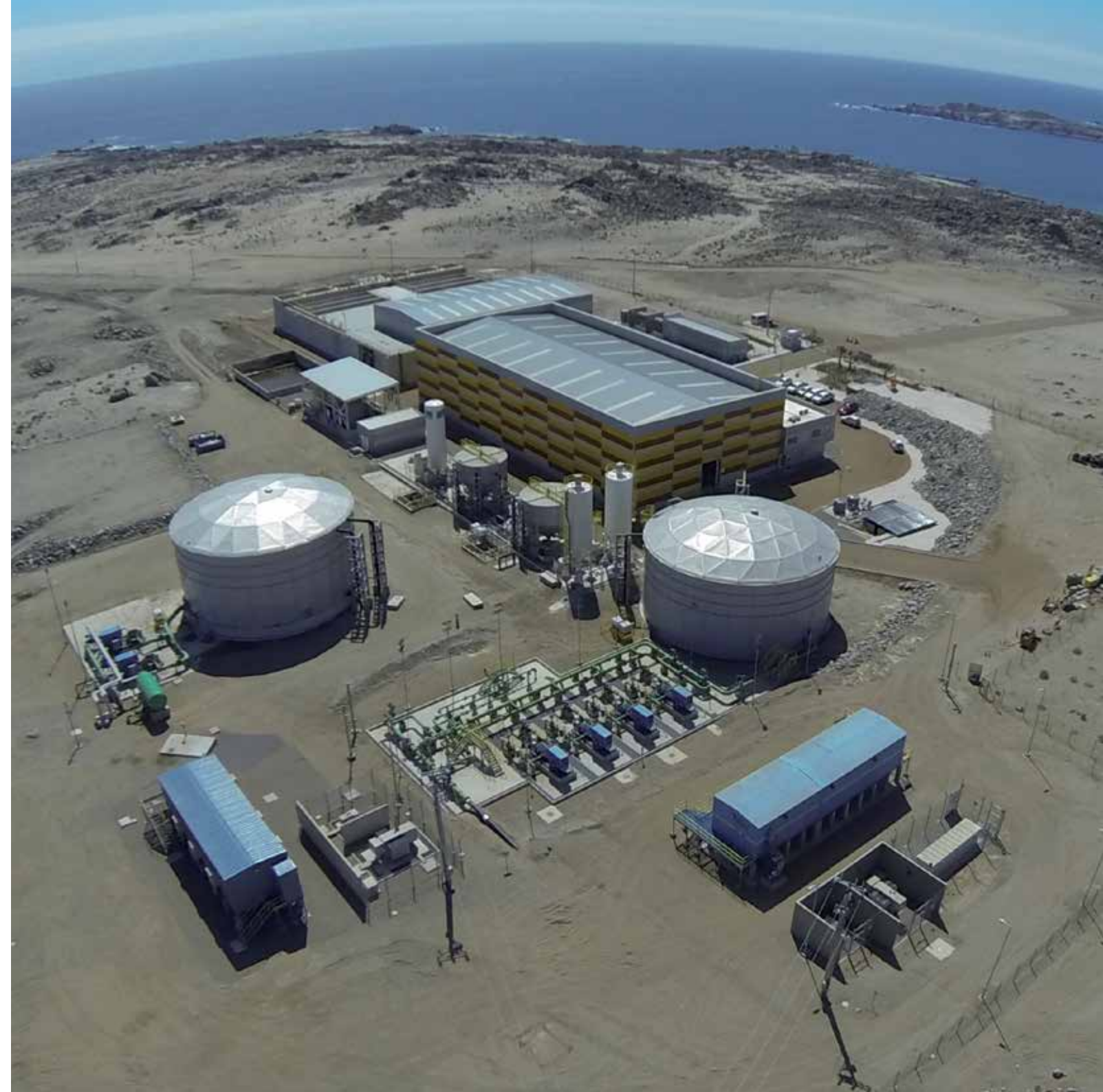
Copiapó desalination plant, Chile
