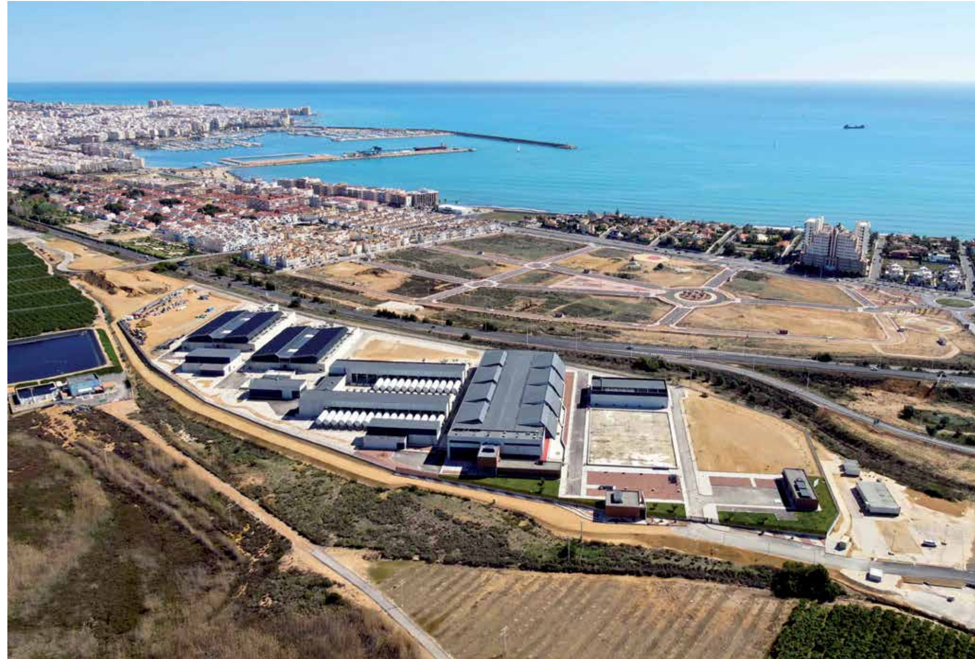
Torrevieja Desalination Plant, Alicante, Spain
