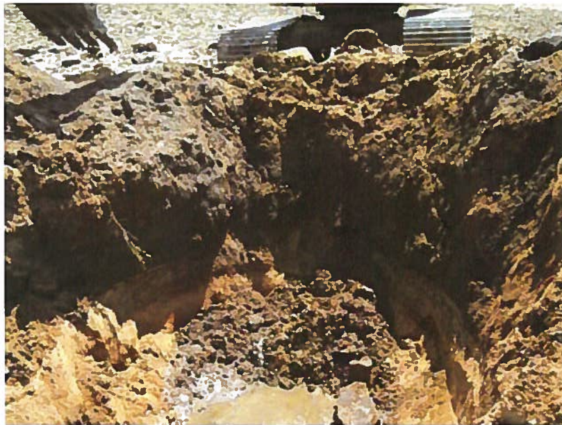
Test Pit: TP-8
