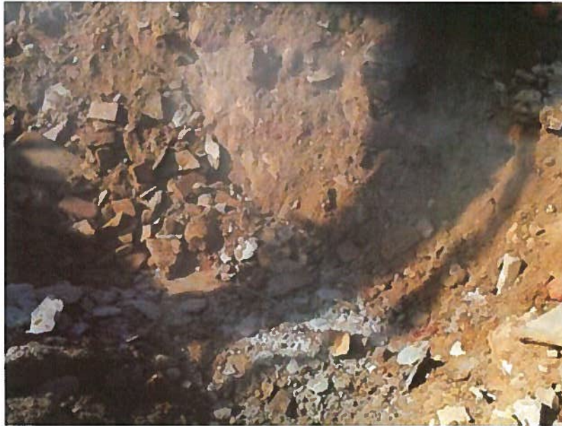
Test Pit: TP-2
