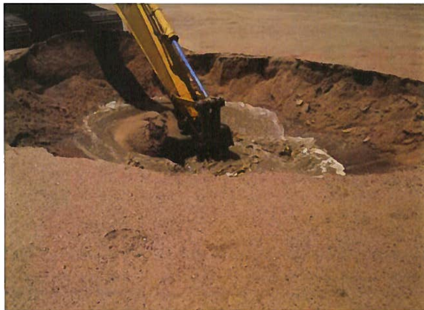
Test Pit: TP-10
