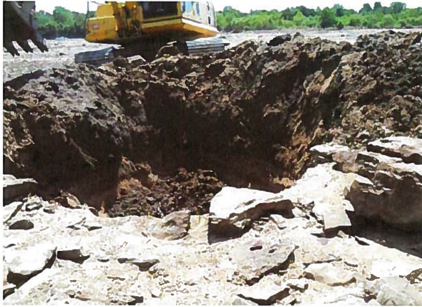
Test Pit: TP-8
