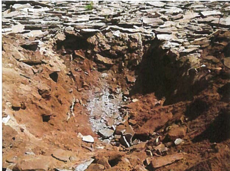
Test Pit: TP-7
