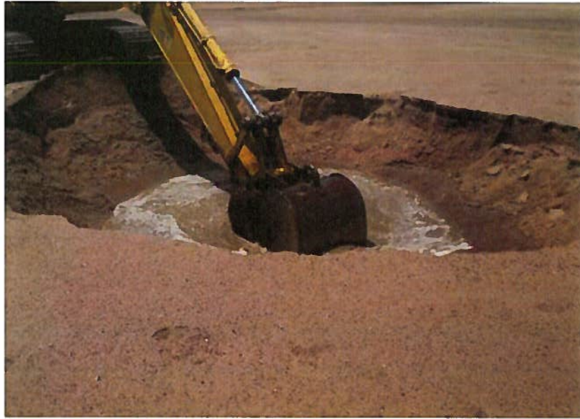
Test Pit: TP-10
