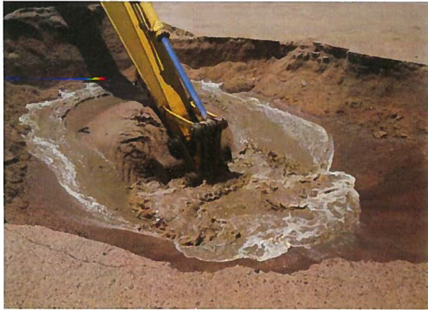
Test Pit: TP-10
