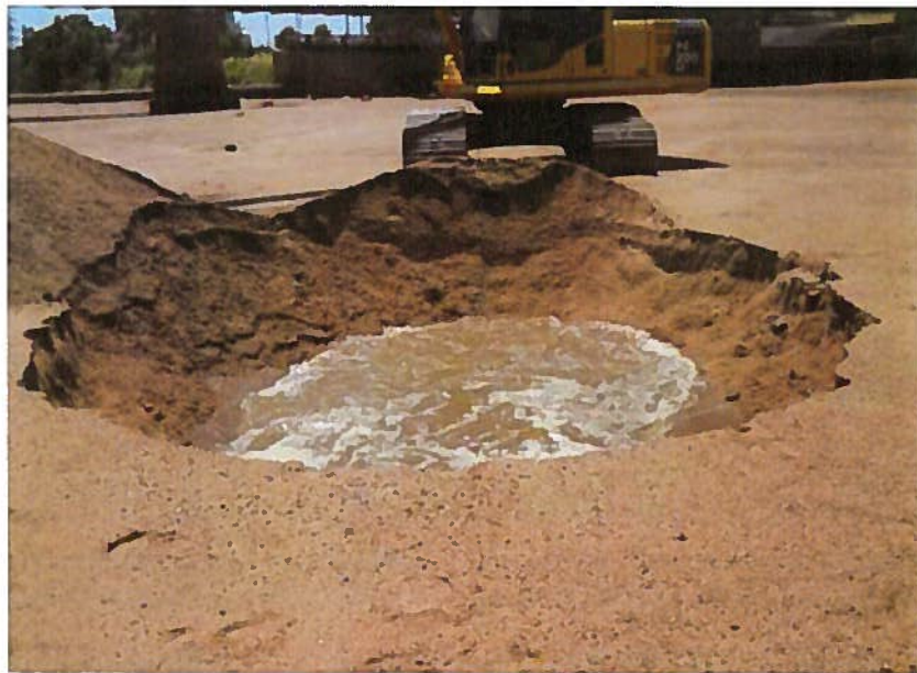
Test Pit: TP-10
